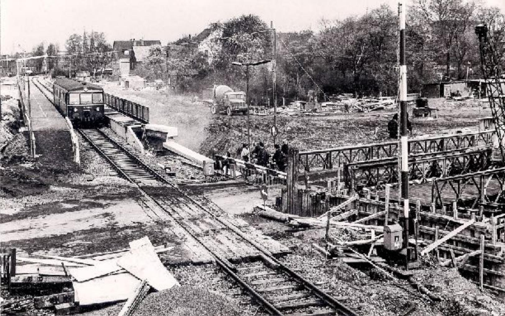
Blick aus dem Stellwerk »Hrb« auf ein Baustellen-Chaos pur. Der Triebwagen befindet sich auf der neuen Eisenbahnbrücke mit dem Haltepunkt »Herne-Rottbruch«. Im Hintergrund ist der Bahnübergang »Am Frauenplan« zu erkennen, rechts eine Behelfsbrücke Richtung Grenzweg. Umfangreiche Erdbewegungen stehen bevor. Heute verläuft hier in der Tiefe die A43.
