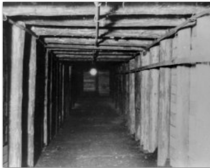
Luftschutzraum der Zeche Mont-Cenis.
